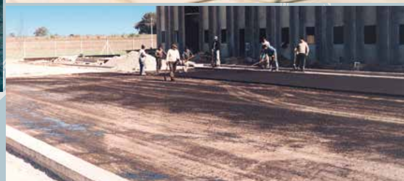
Laboratorio Creón Zona: Pilar - Pcia. Bs. As. Construcción de 2.500 m 2 de piso.
