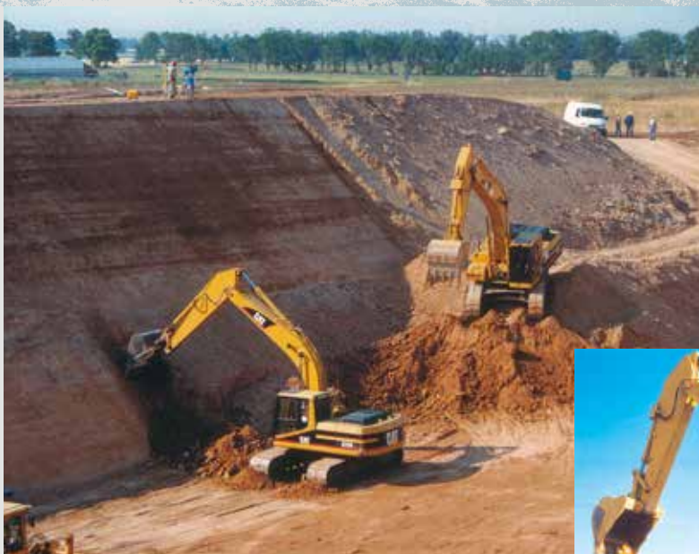
Gobierno de la Provincia de Buenos Aires Zona: Suipacha Pcia. Buenos Aires. Provisión y ejecución de suelo cemento para tramo de ruta provincial 240.000 m 2 . Camino de acceso, terraplén con compactación especial, ejecución de suelo cal y suelo cemento: 15 Km. lineales.
