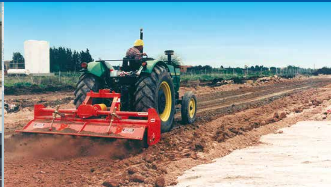
Gobierno de la Provincia de Buenos Aires Zona: Suipacha Pcia. Buenos Aires. Provisión y ejecución de suelo cemento para tramo de ruta provincial 240.000 m 2 . Camino de acceso, terraplén con compactación especial, ejecución de suelo cal y suelo cemento: 15 Km. lineales.
