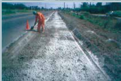
Ruta Nro 3 Zona: González Catán Pcia. Buenos Aires. Construcción de banquetas, suelo cal, base granular 10 km.
